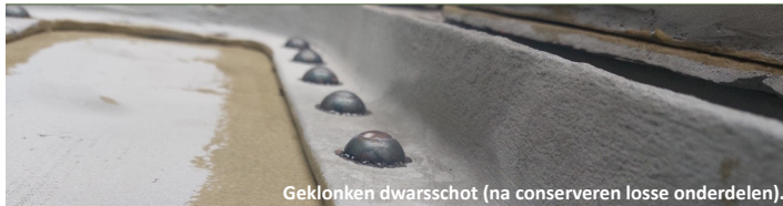
Geklonken dwarsschot (na conserveren losse onderdelen).
