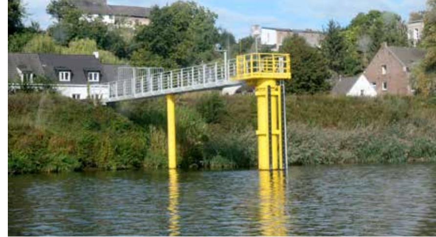
Meetpaal met loopbrug in de Maas bij Maastricht
