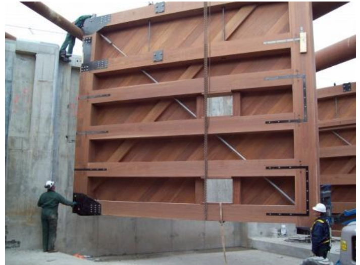
Foto: aanbrengen van één van de sluisdeuren eind 2010
